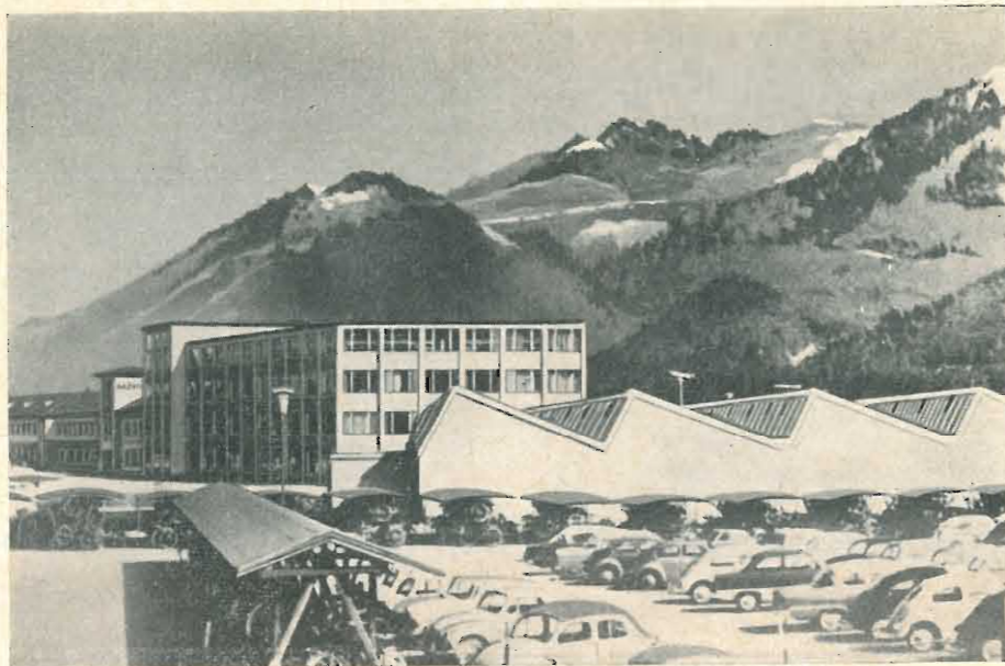
Veduta generale della fabbrica KÖRTING RADIO WERKE a Grassau/Chiemgau nella Germania meridionale.
